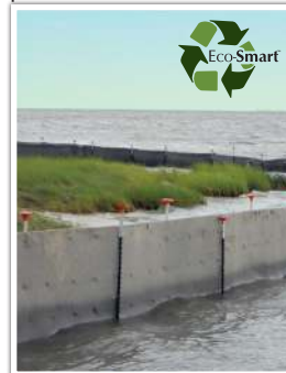
1460 : long de 5 m (16 pi) hauteur de 2 m (6 pi)
