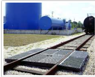
9566: foso central con rejilla
